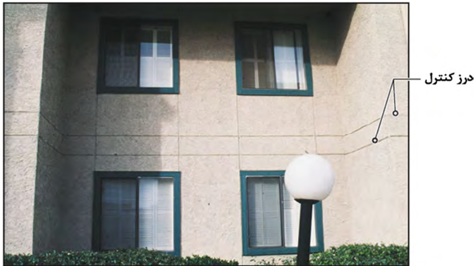
شکل ۶-۸- نمونه درزهای کنترل بر روی نمای سیمانی
