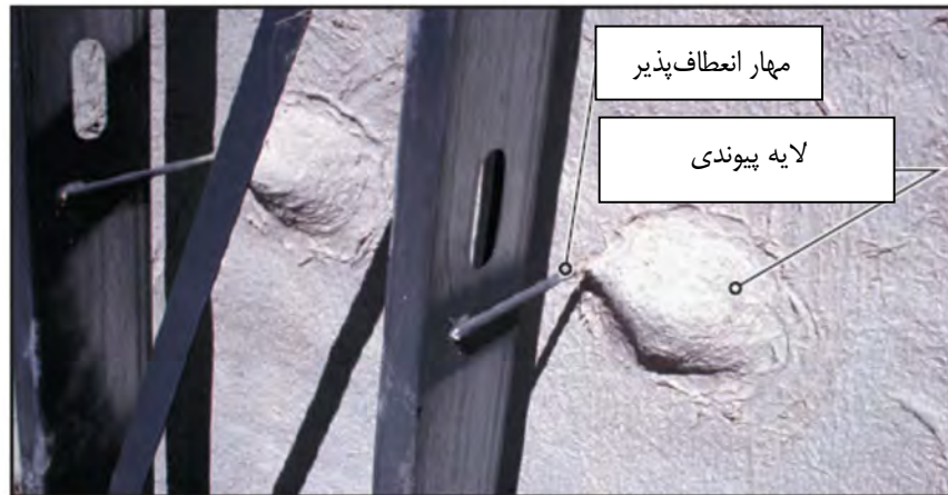
شکل ۶-۳۸- لایه پیوندی و مهارهای انعطاف‌پذیر
