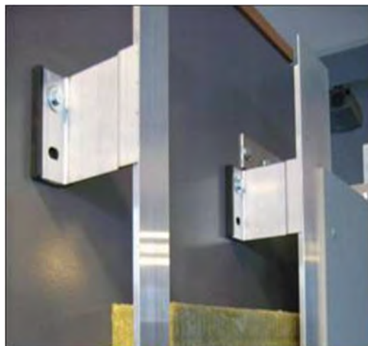
شکل ۶-۴۵- نمونه‌های زیرقاب ساخته‌شده با قطعات آلومینیومی
