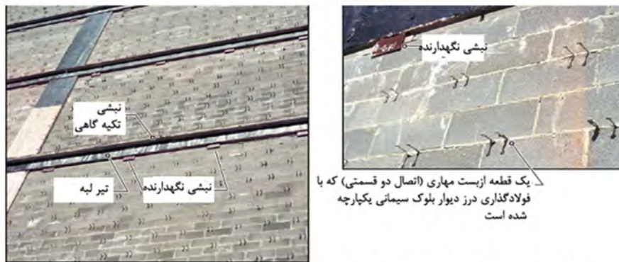
الف - نشی های نگهدارنده به زیر تیر لیه اتصال می یابد. فواصل این نشی ها تابع بار جانبی اعمال شده به دیوار است.
