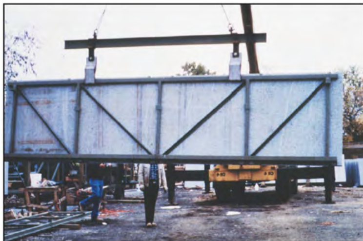
شکل ۴-۲۵- پانل دیواری پرده‌ای پیش‌ساخته سنگی
