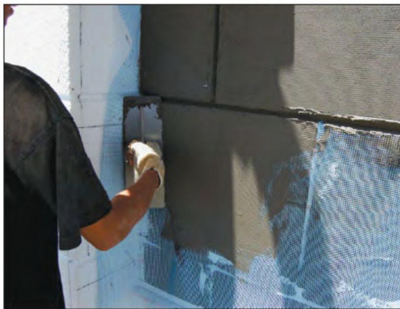
شکل ۶-۱۸- اجرای لایه‌های پوششی
