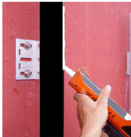
شکل ۷-۲۵- اجرای رشته‌ای از بتونه بر روی پروفیل قائم
