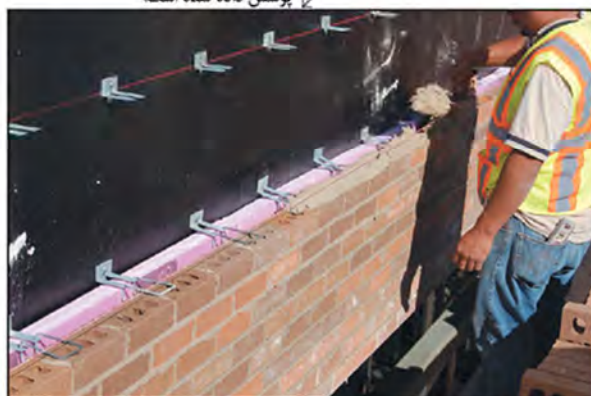
ب- بست دو قسمتی شامل ورق فلزی و بست مهارتی سیمی که برای قطعات پشتیبان بتن آرمه (دیوار، تیر و ستون) به کار می رود
