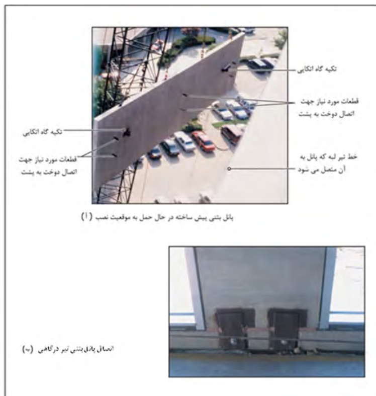
شکل ۳۱-۶- تیپ اتصالات دوخت به پشت که در سه جهت قابل تنظیم می باشند
