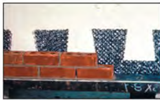
ب- وسیله مهار ملات که در فضای خالی نصب شده است.
