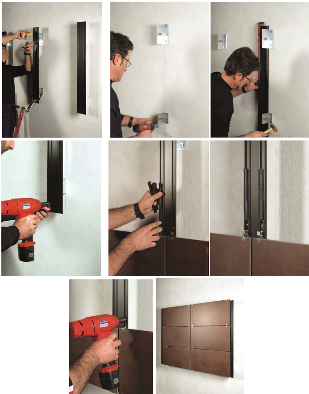
شکل ۷-۲۴- مراحل نصب سیستم نصب نمایان
